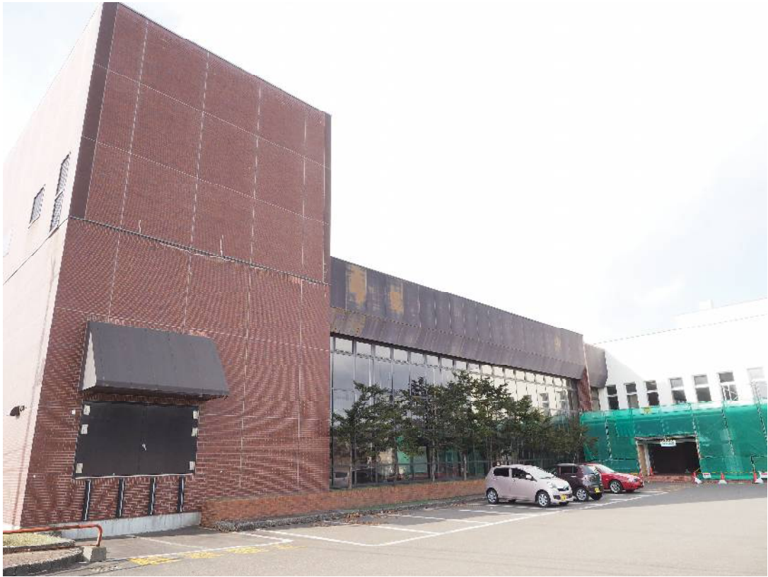
白老町コミュニティーセンター（白老町中央公民館）
