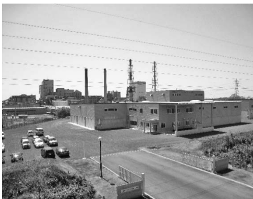
今年3月末で事業廃止する バイオマス燃料化施設
