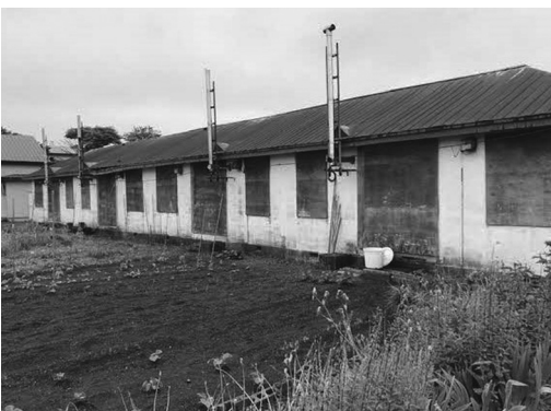
末広団地の建設に伴い解体される西団地（高砂町）
