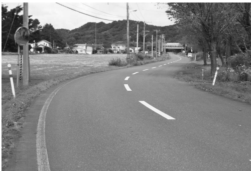
歩道が未設置の町道陣屋線
