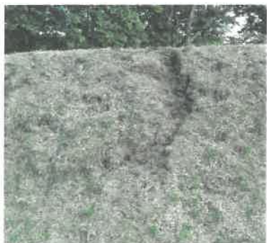
土塁の崩落状況（獣害）
