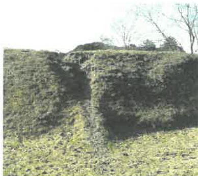
土塁の崩落状況（踏み荒らし）
