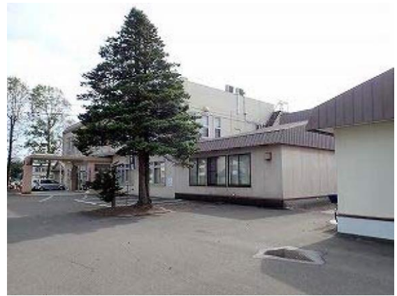
【北西側から見た現庁舎】
